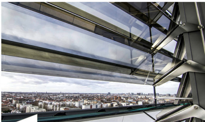
Wind- und Sichtschutz sowie Stauwärmeabführung über automatisierte Fenster in einem exklusivem Wohnhochhaus
