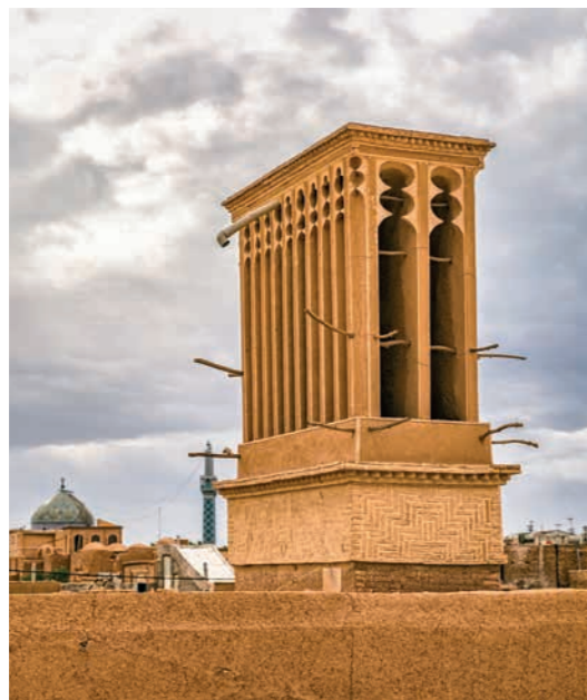
Optimal natürlich belüftet: ein antiker persischer Windturm und das moderne Wohnobjekt Four Winds in Istanbul
