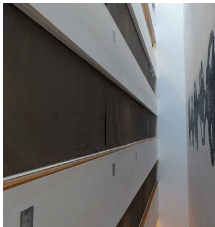
Luftraum im Jakob-Kaiser-Haus mit und ohne selbsttätige „mobile“ Rauchschürze (v.l.).
